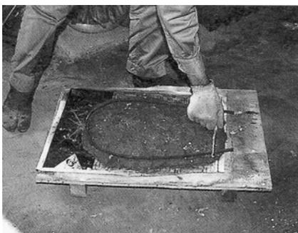
2 水分を取り除き、鉄筋てっきんで補強し、もう一度粘土を貼る。
